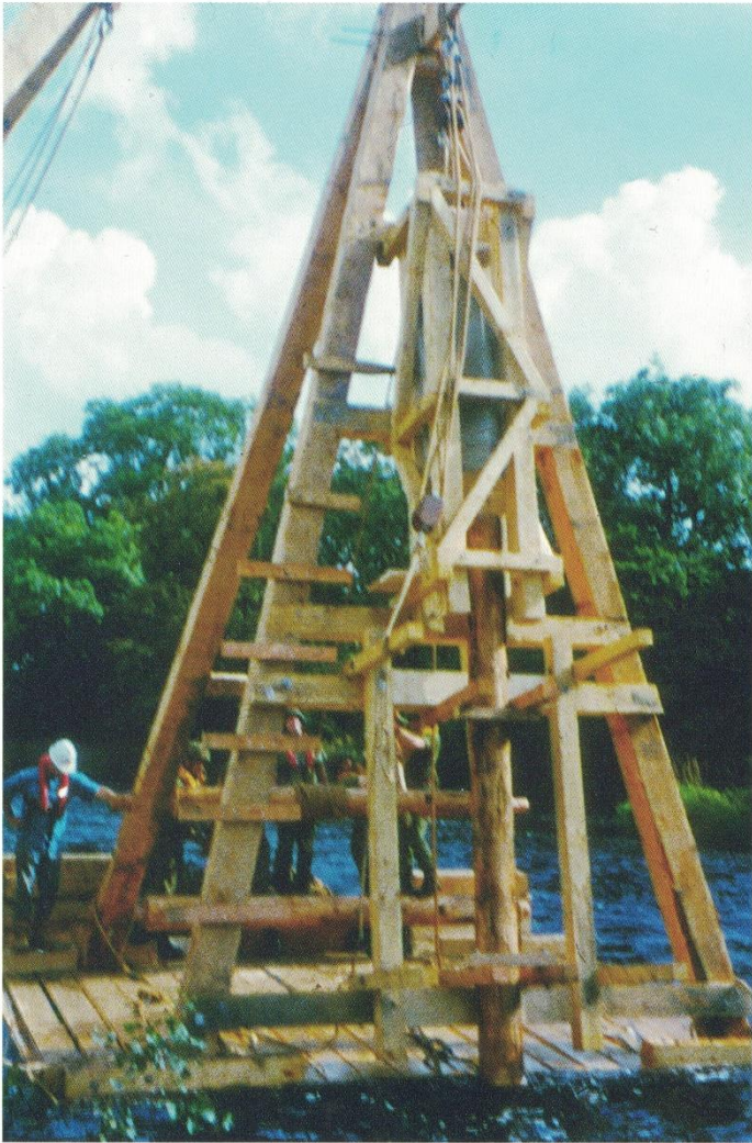
River Tyne, England. Auf dem Floß errichtete Pfahlramme mit Korb zur Aufnahme des Rammgewichts. Darunter die Führung für den Pfahl. Foto: H. Fehr.
